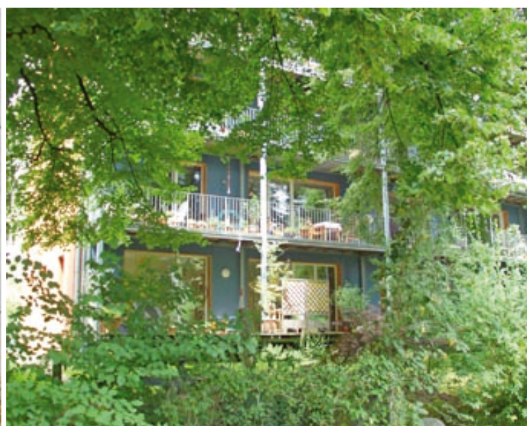
Le tableau du bord de la centrale de cogénération (à gauche). De tels tableaux de bord se trouvent devant un certain nombre d'installations ayant une vocation écologique, montrant la production, la consommation des ressources, les économies réalisées. La façade sud du Baugruppe « Wohnen und Arbeiten » avec ses grandes baies vitrées, ombragées en été grâce au rebord des terrasses et aux arbres. En hiver le soleil, plus bas, rentre pour chauffer l'intérieur, les arbres ayant perdu leur feuillage.
