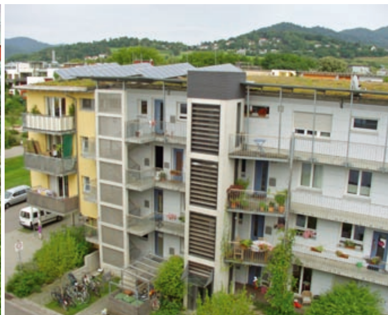
Les fossés (à gauche) sont normalement vides : ils retiennent l'eau de pluie jusqu'à leur réabsorption par le sol. Les toitures végétalisées sur une épaisseur de terre peu profonde (à droite) s'arrosent en captant une partie de l'eau de pluie.
