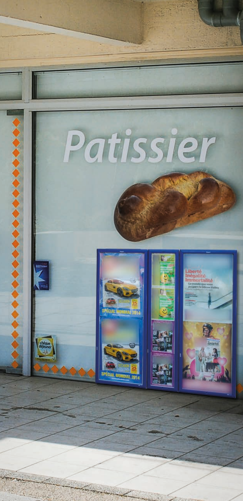
Un exemple de micro-affichage recouvrant en partie une baie de devanture commerciale.
