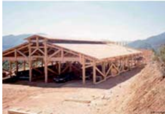
Bergerie dans les Alpes de Haute-Provence Maître d'œuvre : Michel Coulache / Surface : 1312m 2
