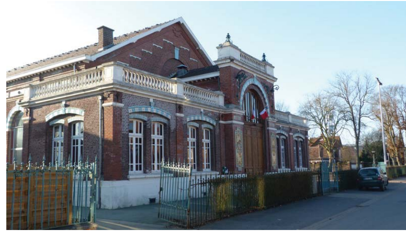
2 : Angle de la façade Sud depuis la rue Taffin.
