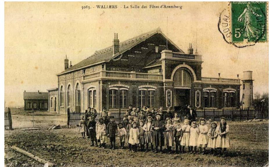
Cartes postales ancienne montrant une vue frontale et latérale de la salle des fêtes. Cl. Mairie de Wallers, Dossier DRAC.
