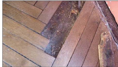
Couche bitumineuse située sous le parquet.
