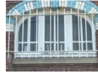
H Locaux non aménagés et local technique (x3)
