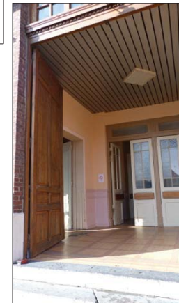
Vestibule depuis l'entrée
