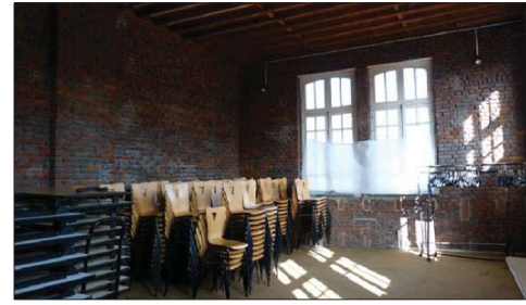
Bibliothèque : vue depuis l'entrée
