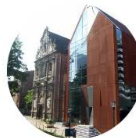
Extension de la Chapelle les Brigittines, Bruxelles ©Sum project
