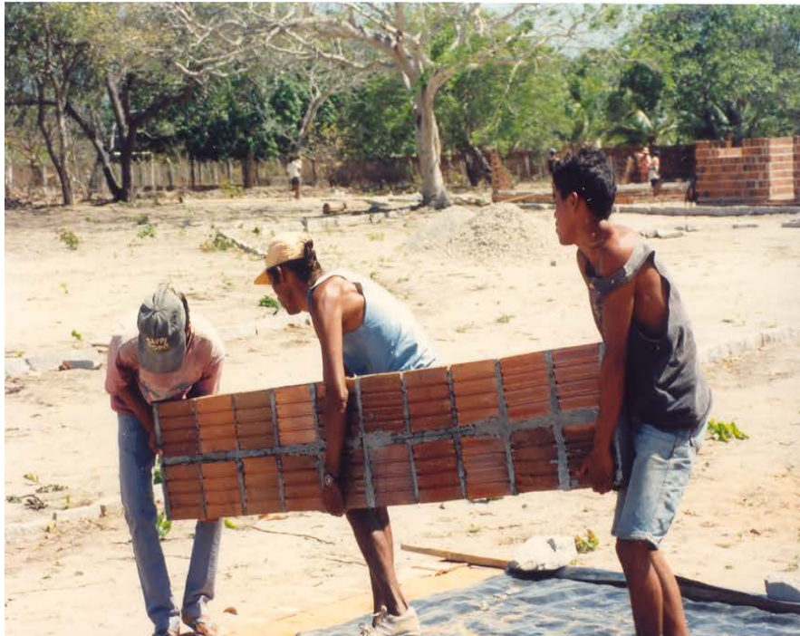
Figure 53 : Habitants du « planalto Benjamin » manipulant les plaques préfabriquées par les femmes pour la réalisation de leurs logements en «aide mutuelle. Projet COMUNIDADES, photo Eric Ruiz, 1993.
