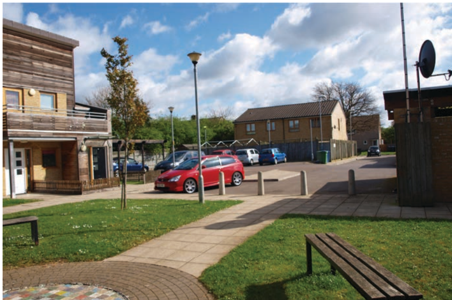
Figure 73 : Opération « Mya Court ». Changement de revêtements et bornes béton, formalisant la limite extérieur/intérieur du projet. Photo Eric RUIZ.
