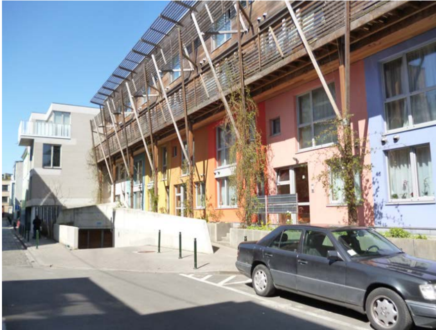
Figure 72: Façade principale de l'opération de « la rue Fin », photo E. RUIZ.
