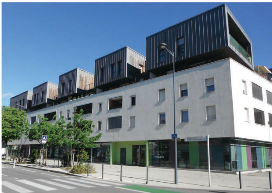
Figure 69 : Façade de l'opération « les Dominos ». Rez-de-Chaussée très ouvert : équipement public totalement vitré. Photo E. RUIZ.
