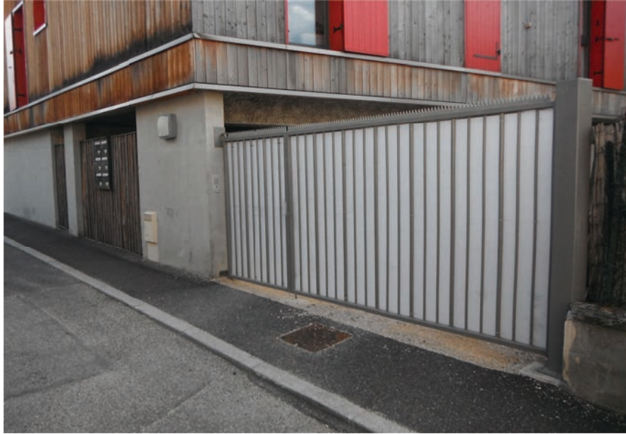
Figure 58 : Façade principale, entrée de l'opération « La Salière », qui « ouvre » sur les espaces communs partagés. Photo E. RUIZ
