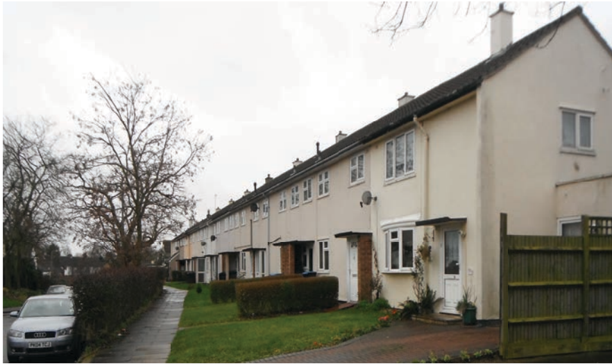
Figure 111 : Opération « Mya Court », voisinage immédiat constitué exclusivement de maisons individuelles. Photo E. Ruiz.
