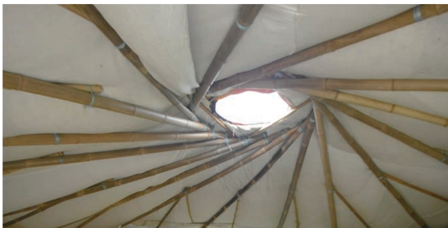
Figure 82 : Expérimentation d'une charpente en bambous récoltés sur le site. Cette technologie a été reprise par plusieurs autres auto-constructeurs. Opération « Sud Ouest », expérimentation de charpente en bambous liés, photo E. Ruiz.
