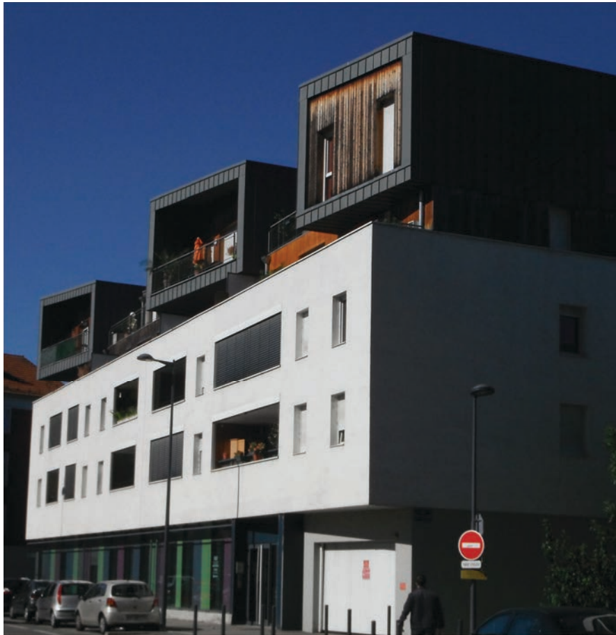
Figure 76 : Façade Est de l'opération « les Dominos », photo E. RUIZ.
