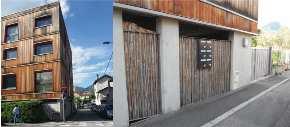
Figure 70 : Façade et rez-de-chaussée très fermé de la façade principale de l'immeuble de « la Salière ». Photo E. RUIZ.
