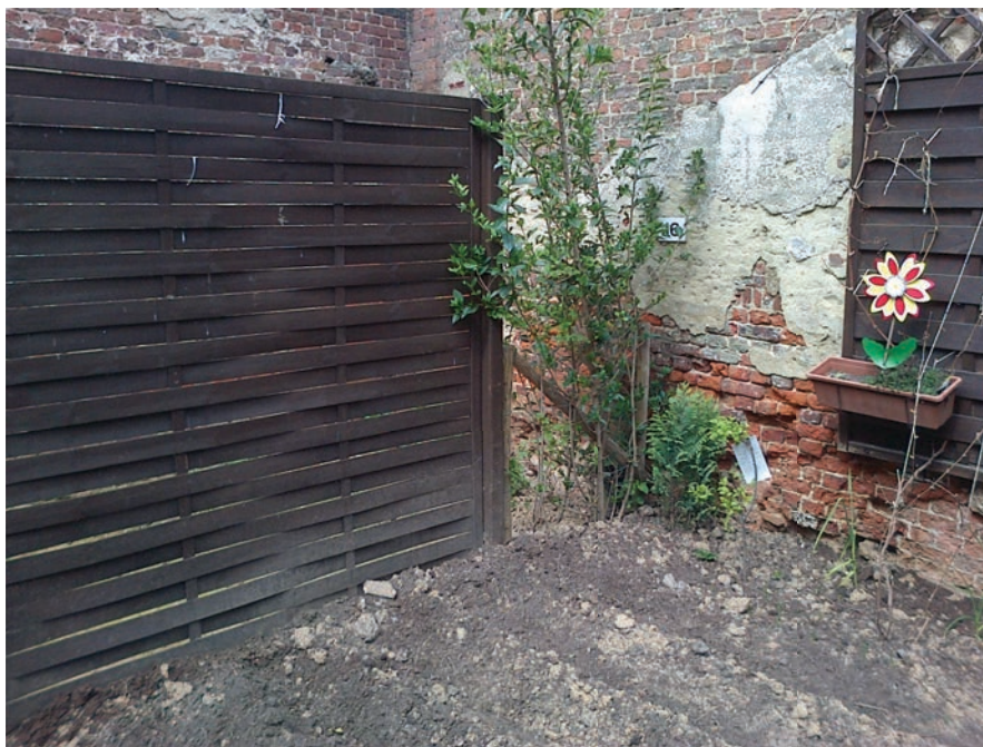
Figure 99 : Espace laissé pour « s'échapper en cas d'incendie » au fond de la parcelle individuelle. Opération « la rue Fin ». Photo E. Ruiz.
