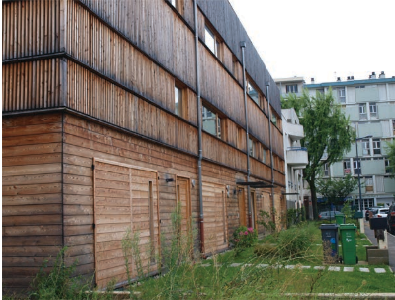
Figure 75 : Opération « Chemin Villebois », façade ouverte, sans volets sur rue et RdC fermé. Photo L. Gaillard.
