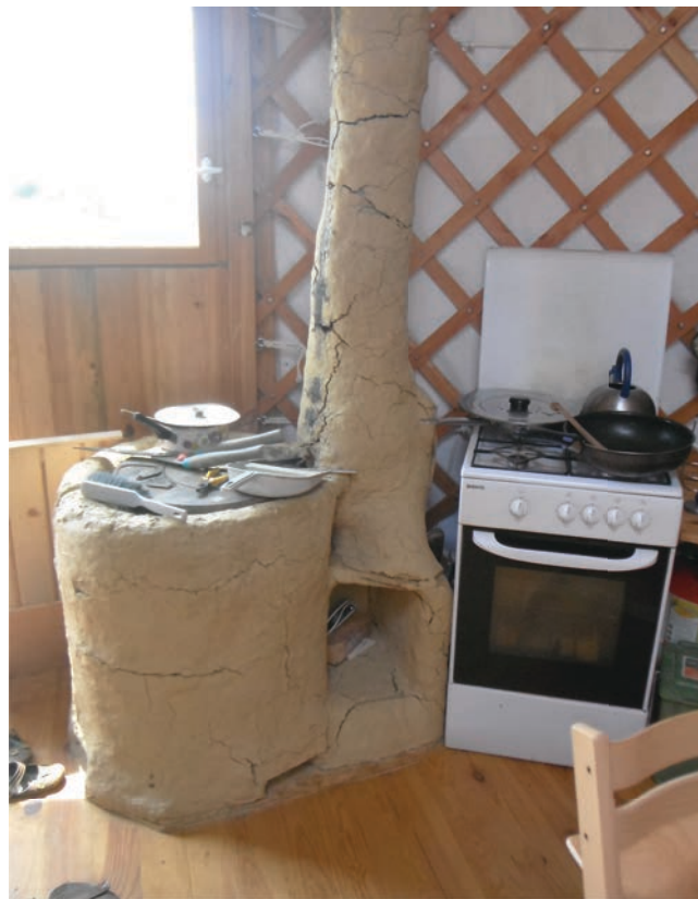
Figure 84 : Expérimentation de poêle de masse, en terre, auto-construit, reproduit dans la majorité des habitats du programme, Opération « Sud-Ouest », photo E. Ruiz.
