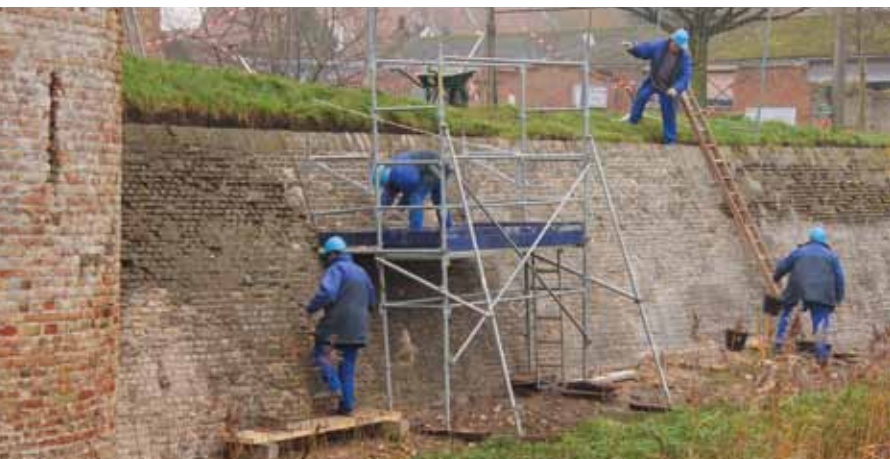
Chantier de restauration à Bergues © P. Houzé.
