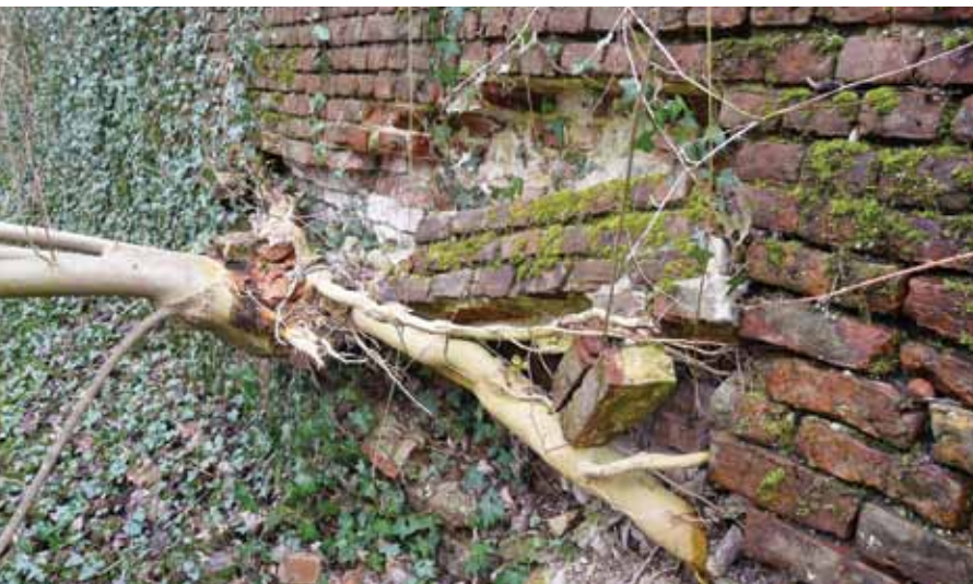
Frênes, saules, sureaux, ormes, érables, arbres à papillons... nombreux sont les arbres et arbustes qui colonisent les maçonneries. © Y. Tison.
