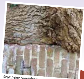
Vieux frêne régulièrement recépé sur le couronnement.
