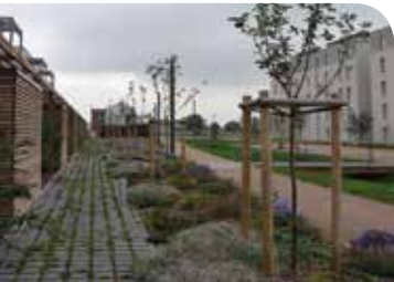
Limite entre espace privé et public à Cébazat (63) - Conception espace public : Sycomore - Source : T. Racault
