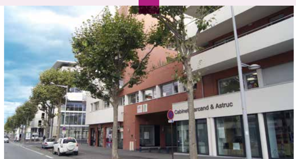
Immeuble mixte, stationnement et passage couvert, rue de la République à Clermont-Ferrand (63) - Archi : Bruhat & Bouchaudy - Source : CAUE63
