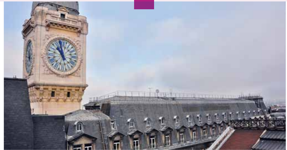
Tour de l'horloge de la gare de Lyon - Archi. : Marius Toudoire - Source : M. Astier
