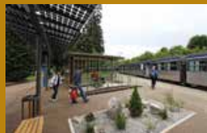
Halte ferroviaire de Niederbronn-les-Bains (67) - Archi. : AREP - Source : ?
