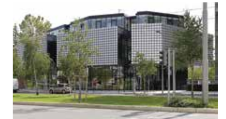
Station Mobile à Grenoble - Archi. : Heralut Arnod Architectes
