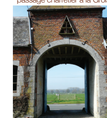
Passage charretier vu de l'intérieur
