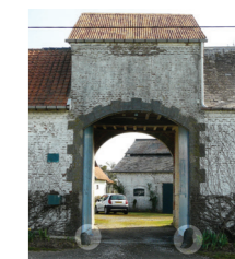
Chasse-roue au pied d'un passage charretier à la Groise
