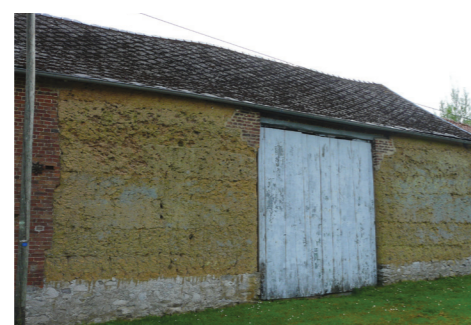
Grange à Catillon-sur-Sambre (torchis, briques et silex en soubassement)
