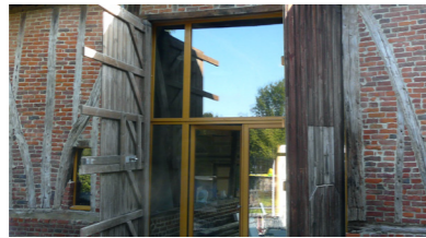
Porte de grange transformée
