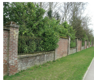
Alternance de murs en briques et grilles en fer forgé à Forest-en-Cambrésis
