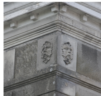
Entablement orné de masques grotesques et fausse chaîne harpée en ciment moulé
