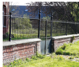
Grille et portail en fer forgé à La Groise
