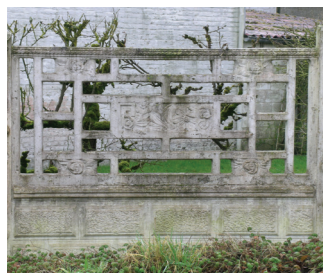
Clôture en ciment armé à Ors
