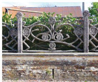
Clôture en ciment armé à Mazinghen
