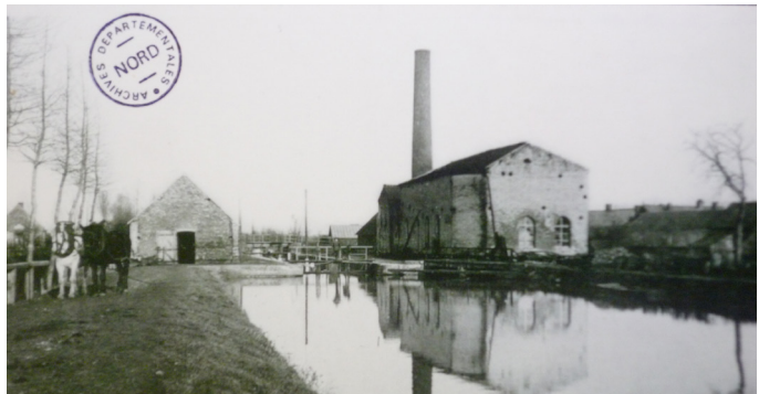
Écluse avec bâtiment de la machine à vapeur alimentant la pompe élévatrice à Ors. On voit également le chemin de halage qui longe la totalité du canal et sur lequel se trouvent deux chevaux qui servaient à tirer les péniches - Carte postale ancienne ADN
