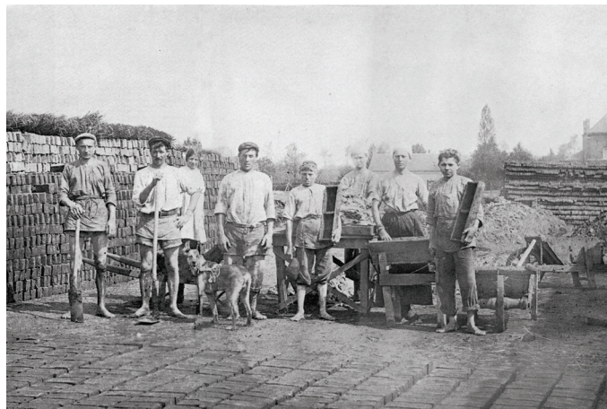
Briqueterie typique. On aperçoit sur le devant de la photographie les briques posées au sol entraînant de sécher. Au second plan, un chien utilisé pour tirer les traîneaux chargés de briques est posté devant les hommes responsables de la préparation de l’argile et un jeune enfant portant un moule à briques. À gauche, les briques empilées sous un lit de branches sont prêtes à cuire (Martine Houze, « Objets, lieux et Coutumes dans l’Avesnois rural » Edit. SERG p36-37)
