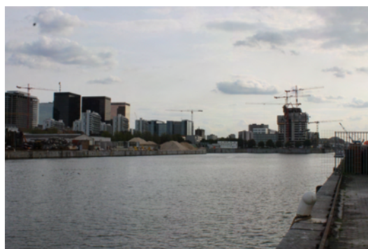
Figure 3.6: la tour Up-Site d'Atenor, en cours de construction (cliché K. Mazy, 2012)
