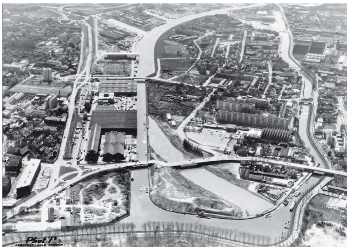
Figure 1.14.: la construction du canal à grand gabarit, en 1977 (Olivier et al., 2011)
