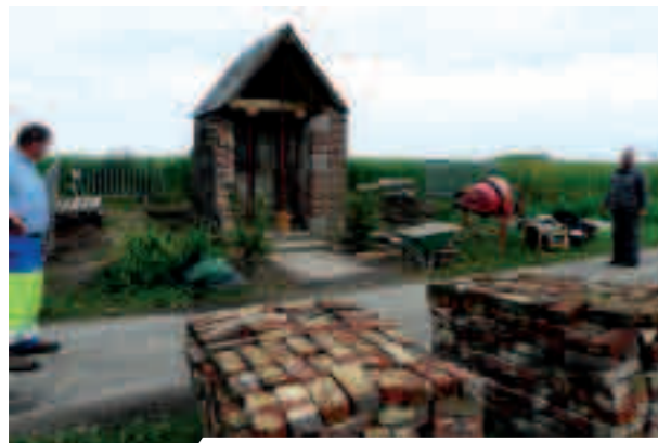
dépose méthodique des maçonneries instables
