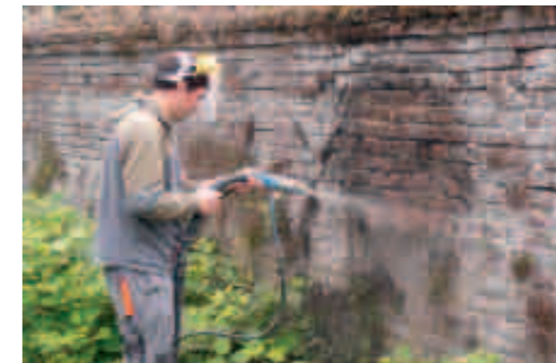
nettoyage par hydrogommage
