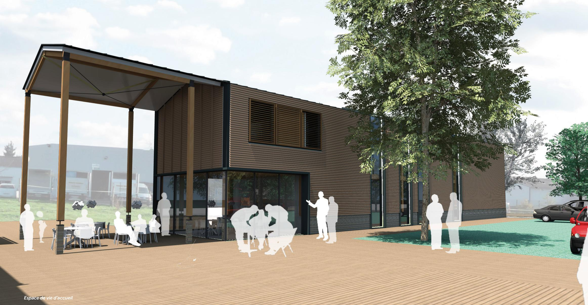
Le projet est basé sur des bâtiments modulables et adaptables, créés en référence aux **typologies agricoles** que sont le hangar ou le séchoir à tabac. Le système constructif, dont les constituants (structure, enveloppe et menuiseries) sont préfabriqués, permet sa déclinaison en un catalogue de bâtiments d'usages variés.
