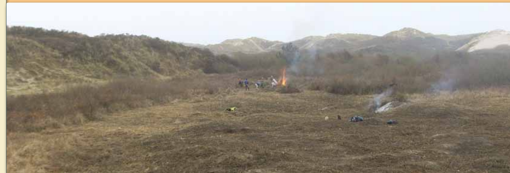
Photo 45 - Chantier de restauration dans une panne du massif dunaire de Merlimont. Les rémanents sont exportés manuellement puis brûlés hors zones sensibles. (© VEILLÉ F. - ONF Pas-de-Calais)
