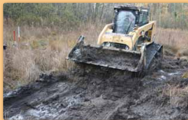
Photo 29 - En milieu tourbeux les travaux de restauration nécessitent bien souvent l'utilisation d'engins spécialisés compte tenu de la faible portance des sols. (© CEN Champagne-Ardenne).
