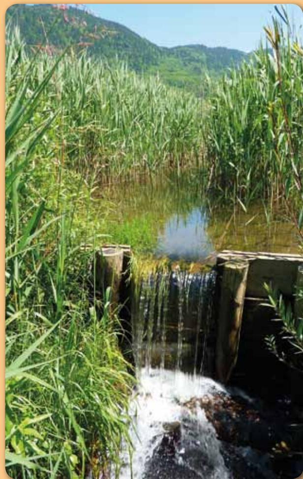
Photo 28 - Seuil installé sur le drain central du marais du Pontet. (© CEN Savoie)
