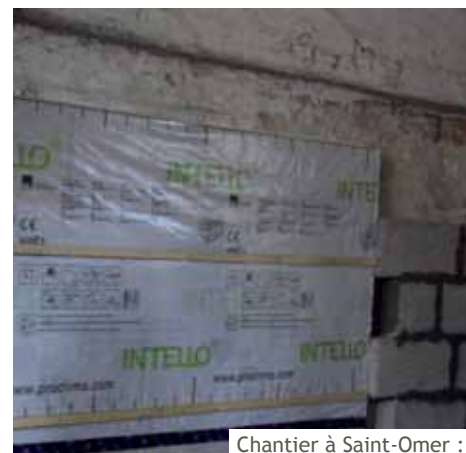
Chantier à Saint-Omer : pose de la membrane d'étanchéité à l'air
