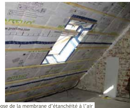
Chantier à Saint-Omer : pose de la membrane d'étanchéité à l'air
