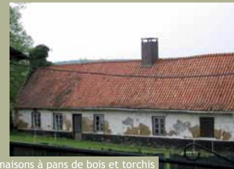
Présence d'enduits cimentés sur des maisons à pans de bois et torchis
