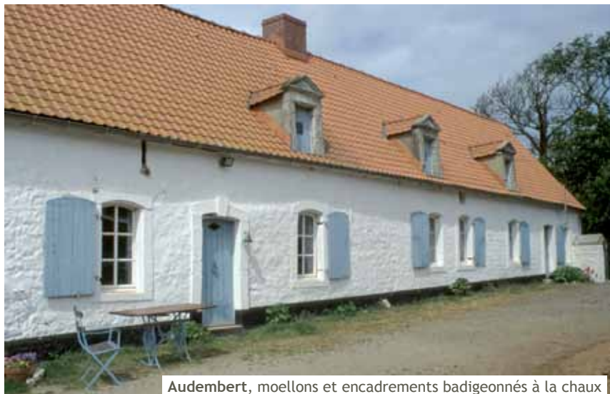
Audembert, moellons et encadrements badigeonnés à la chaux
