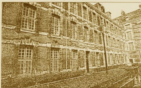
Rue du Lombard, face à la direction régionale des affaires culturelles : le musée deviendra vraisemblablement un immeuble à usage local. Photo J.-L. PITEUX
