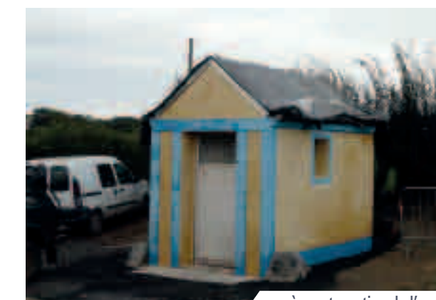
après restauration de l'enduit
