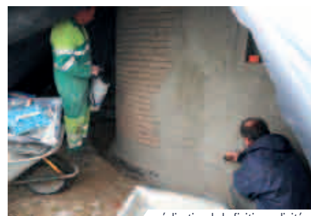
réalisation de la finition « digitée »
