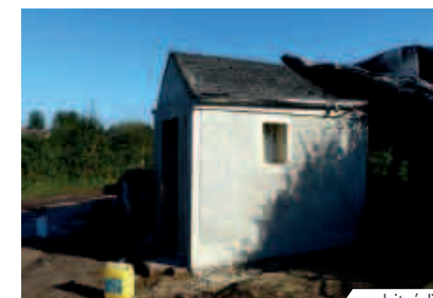
enduit réalisé
