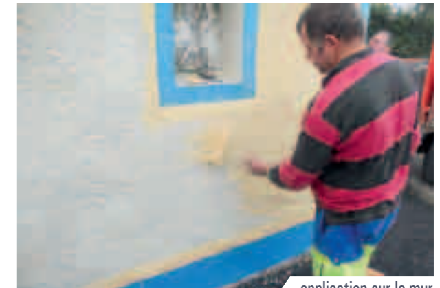
application sur le mur
