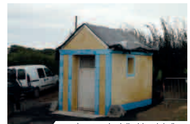
après restauration de l'enduit et du badigeon
