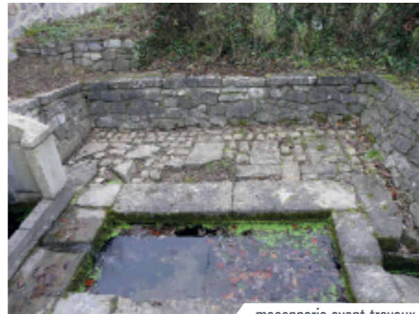
maçonnerie avant travaux
