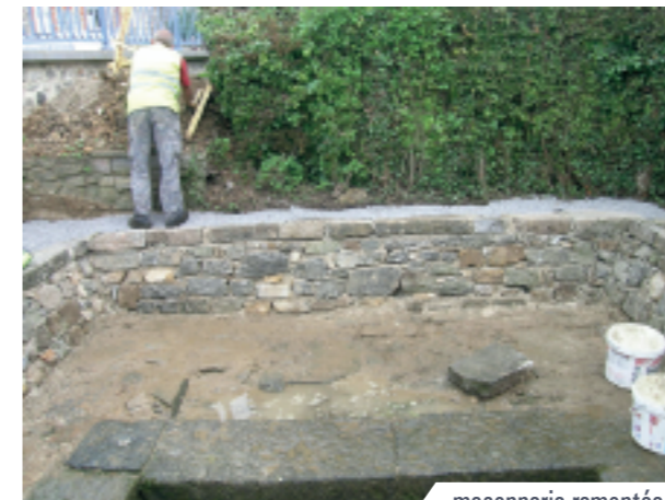
maçonnerie remontée
