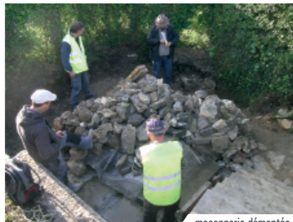
maçonnerie démontée
