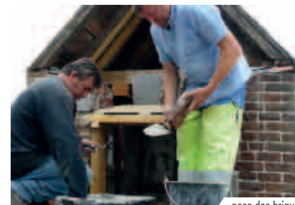
pose des briques
