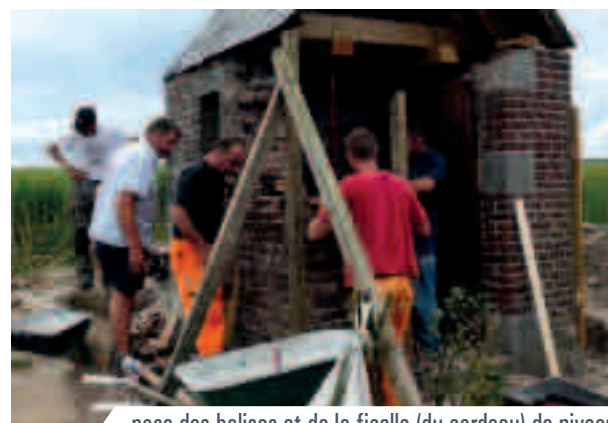
pose des balises et de la ficelle (du cordeau) de niveau
