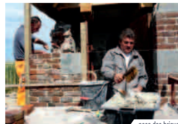
pose des briques
