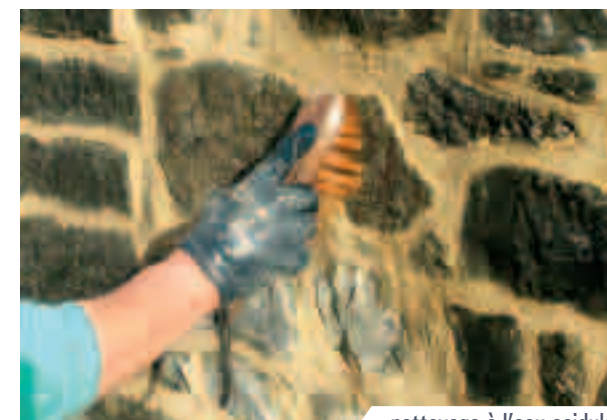
nettoyage à l'eau acidulée
