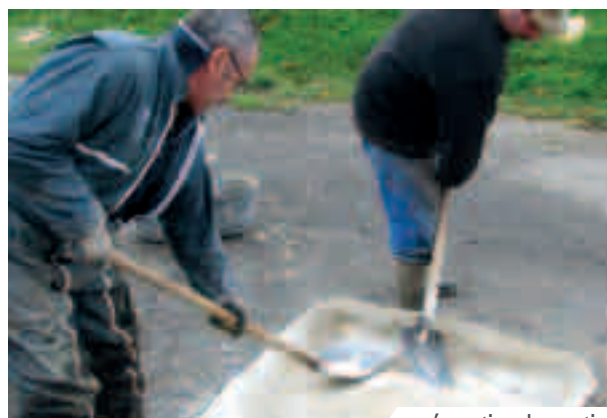
préparation du mortier
