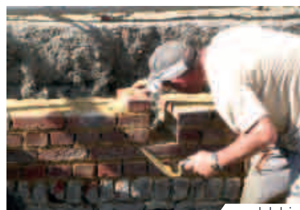
pose de la brique
