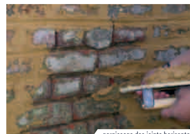
garnissage des joints horizontaux
