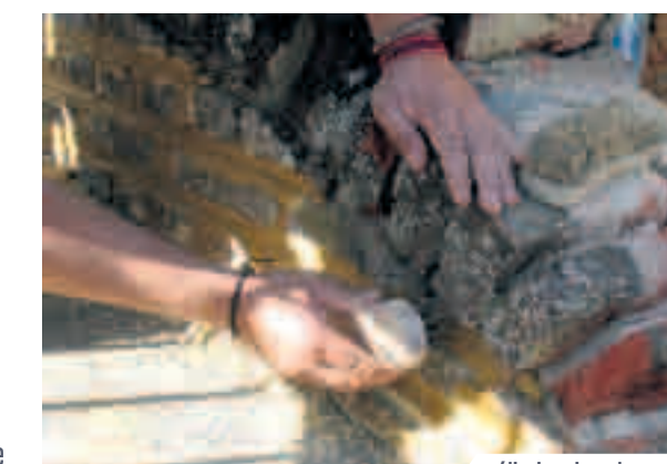
élimination du mortier
