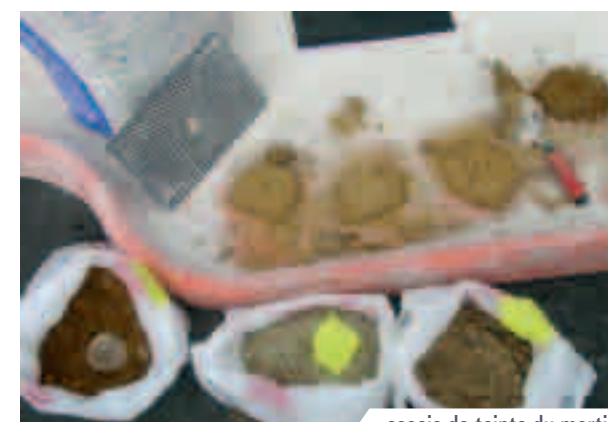
essais de teinte du mortier
