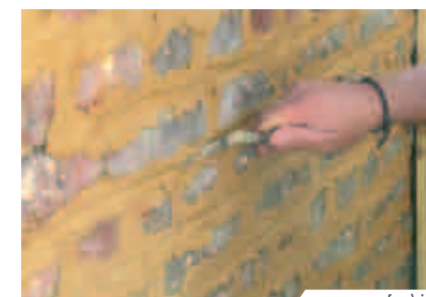
serrage au fer à joint
