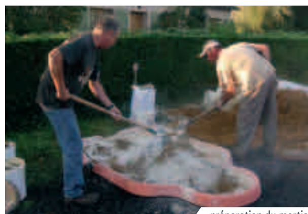
préparation du mortier
