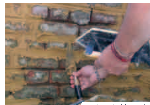
garnissage des joints verticaux
