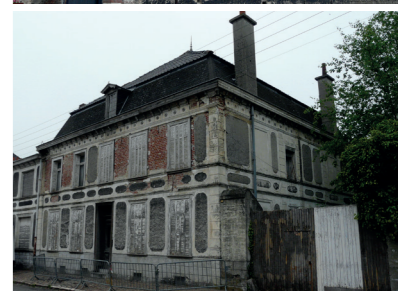
Bâtiments caractéristiques de l'architecture du centre-ville historique
