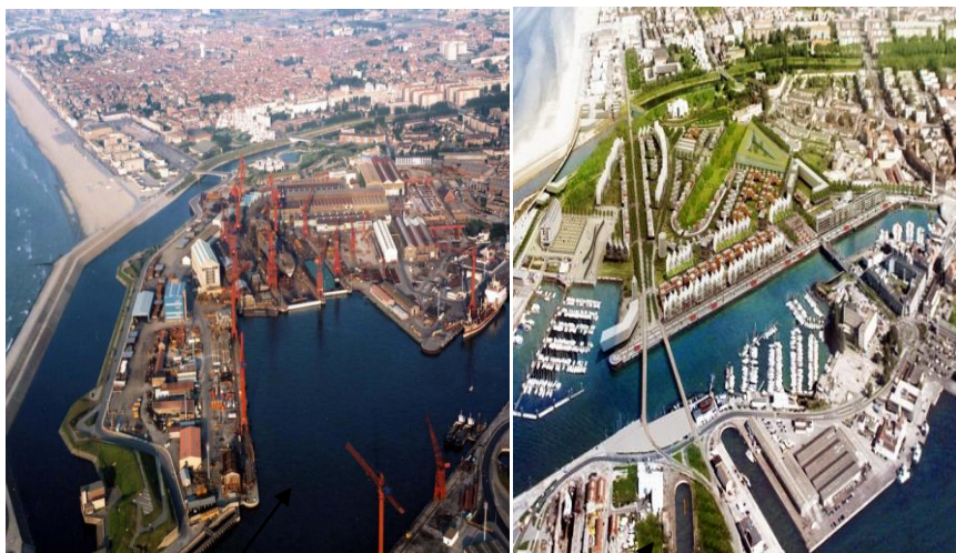
Figure 50 : Vue de la ZAC pendant la période industrielle
