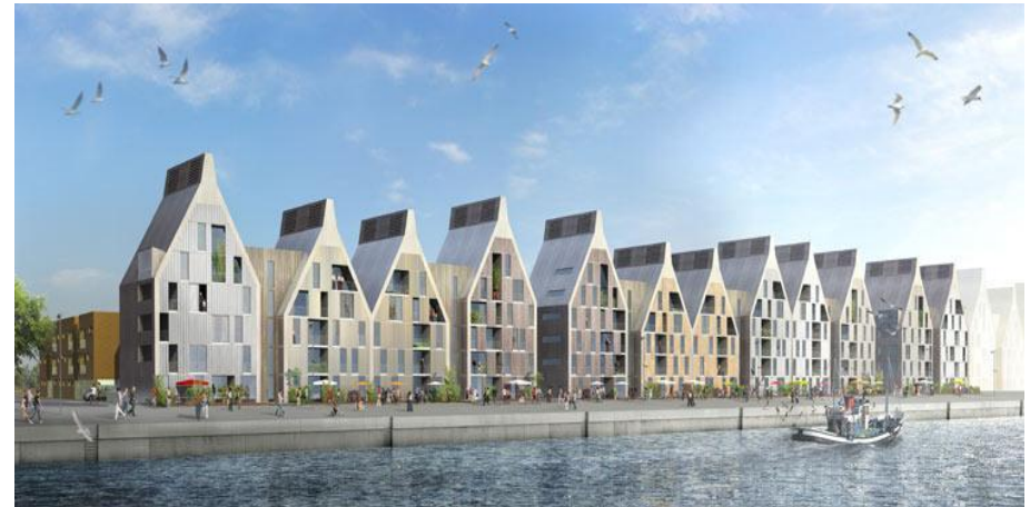
Figure 54 : Immeubles collectifs du quartier Grand large Source : www.solebain.fr.
