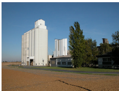
Silos à Boisseaux
