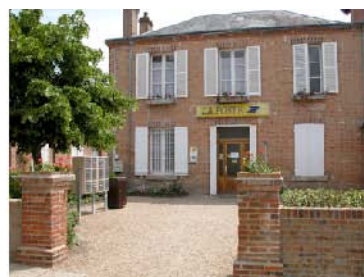
La poste à Ménestreau
