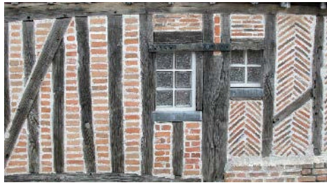
Mur de briques à Ligny-le-Ribault
