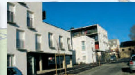
Véritable rue nouvelle créée par les maisons individuelles, les immeubles plots et les collectifs alignés.
