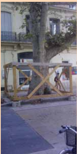
1 - Protection d'un Platanus vis-à-vis des travaux de voiries Montpellier (34)
