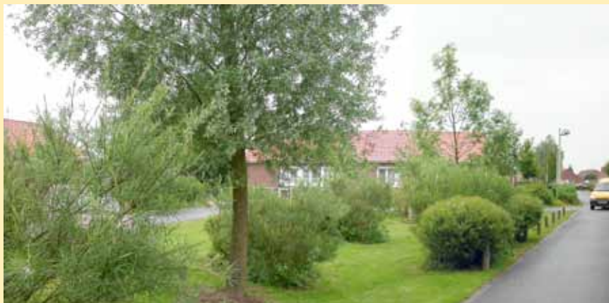
1 - Un délaissé de voirie a été ici aménagé en zone tampon pour stocker les eaux pluviales (large noue). Outre son rôle fonctionnel, cet espace, planté d'arbres et d'arbustes, participe à la qualité du cadre de vie
