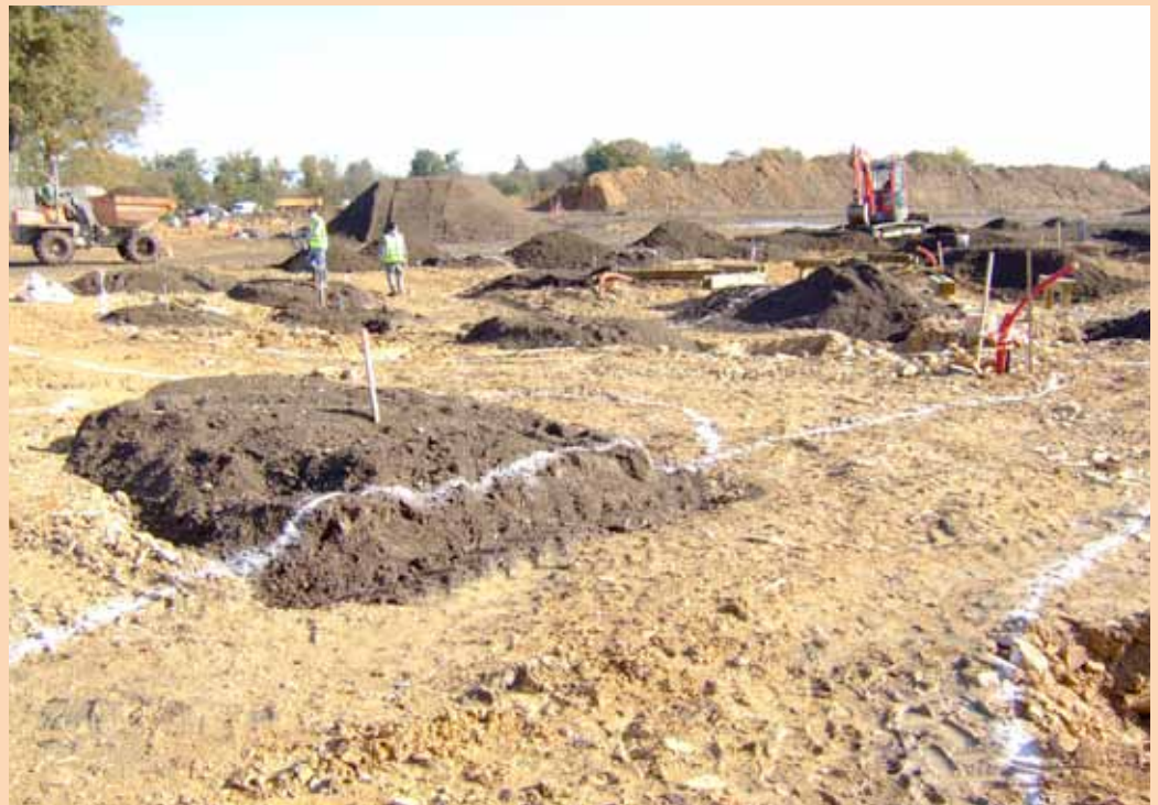
1 - Vue d'un chantier Parc Terra Botanica, à Angers (49)
