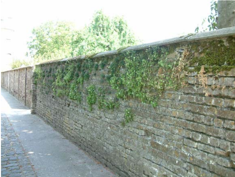
Lo : un mur de brique sépare le jardin du domaine public. Lo : een gemetste muur vormt de scheiding tussen het privé- en publieke domein.
