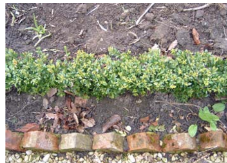
Ochtezeele : bordure en brique en V. Ochtezeele : baksteenboord in V-vorm.
