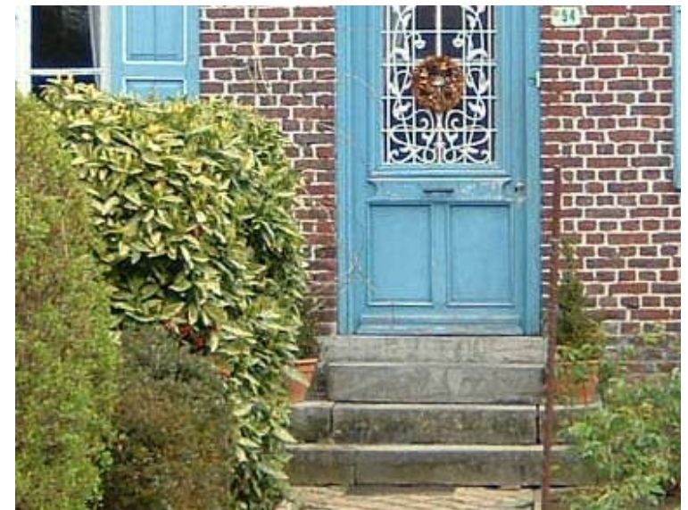
Volckerinckhove : la pierre bleue est souvent utilisée pour les seuils et les perrons. Volckerinckhove : blauwe hardsteen wordt dikwijls gebruikt voor dorpels en stoepen.
