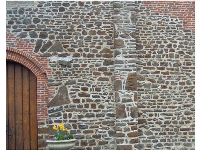
Eglise d'Ochtezeele : le grès ferrugineux constitue un matériau utilisé dans les monts des Flandres, en complément de la brique. Kerk van Ochtezeele : de ijzerhoudende zandsteen afkomstig van het Heuvelland.
