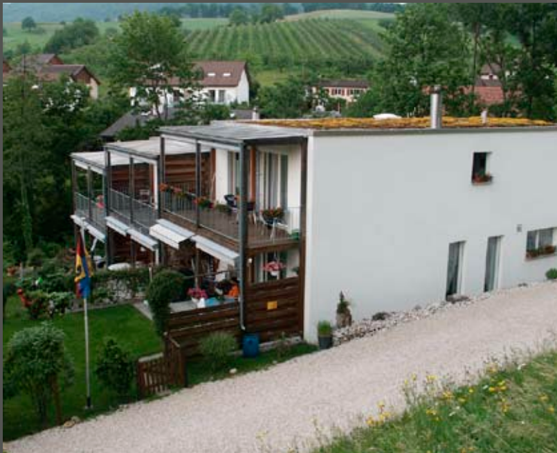
Kuttingen (CH) - logements
