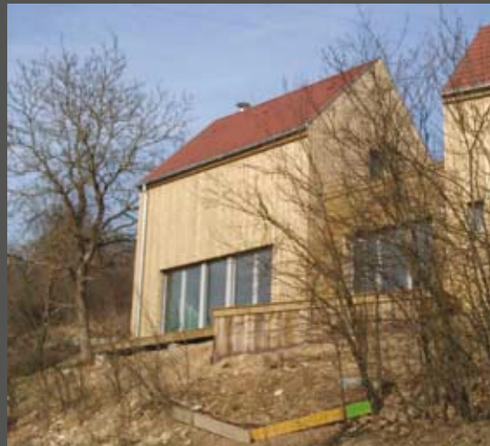
Façade sud ouverte
