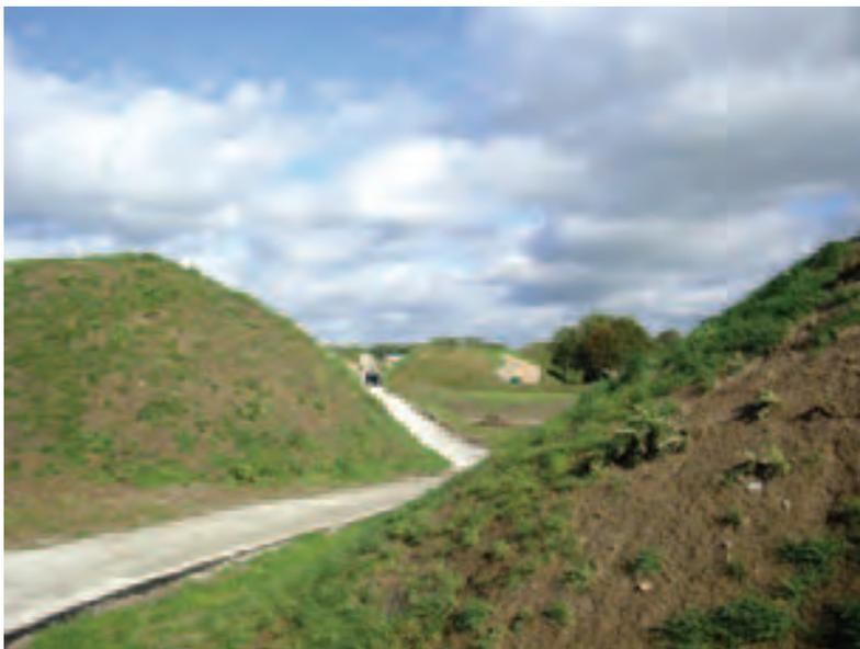
» La tenue des terres sur les talus très pentus recouvrant différents édifices est possible par l'ensemencement des terres et le recours à un tapis tridimensionnel en nylon.
