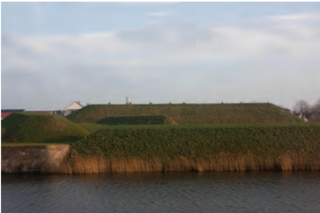
» À Hellevoetsluis, des parties des talus sont exécutées en terre, d'autres ont été consolidées par des murs de soutènement en briques. Cette différence s'explique par l'évolution du génie militaire lors de la construction de la fortification.
