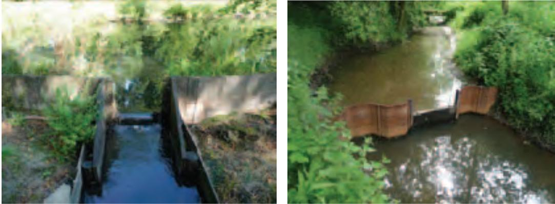
» La mise en place d'un barrage réglable permet de contrôler le niveau d'eau
