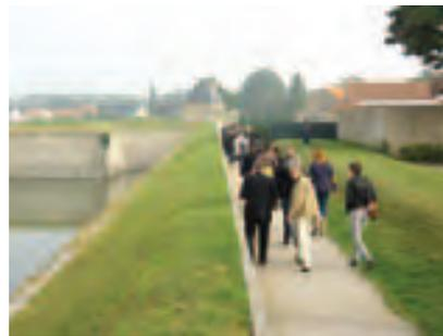
» La valorisation du chemin de ronde a induit la construction d'un mur de soutènement afin de ne pas modifier le profil du talus depuis l'extérieur ; Il est réalisé en éléments en béton préfabriqués. La surface est matricée pour évoquer les planches de bois utilisées historiquement. Projet réalisé par l'Atelier Nervures et financé dans le cadre du projet européen Septentrion, de la ville forte à la ville durable (2003 / 2007) Gravelines (F)
