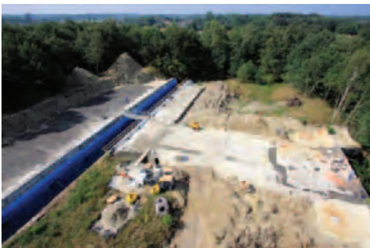
» La couverture de terre a été entièrement retirée lors de la réparation de l'étanchéité de la toiture. Les différentes couches de terre ont été stockées séparément. Le profil du sol a été rétabli à la fin des travaux.
