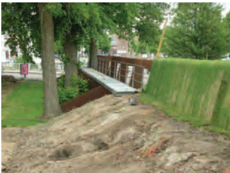
» Reconstitution du profil du rempart avec des lames en acier Corten, permettant la préservation des arbres. s Hertogenbosch (N)
