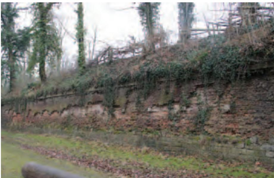
» Combinaison de pierres naturelles et de briques dans l'ouvrage de maçonnerie
