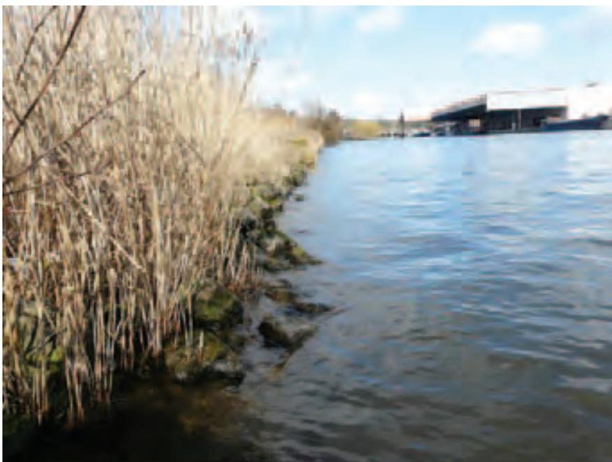
» Une digue en rocher isole la berge en terre en pente relativement douce du batillage, les roseaux et d'autres plantes aquatiques se développent et forment un milieu naturel très intéressant.
