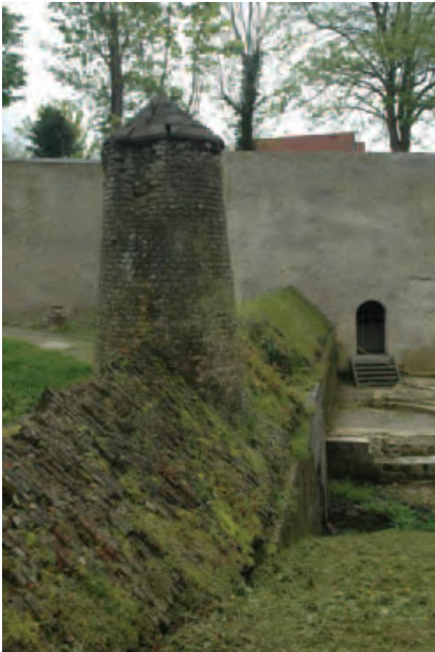
» Un batardeau est une digue maçonnée dans une douve qui pouvait également être destinée à former une séparation physique entre l'eau de la douve et l'eau salée extérieure ou à empêcher l'afflux d'un fort courant d'eau (en provenance de la mer, d'un étang, d'une rivière). Le batardeau possède un faite en pointe (dit « en dos d'âne ») surmonté de tourelles en pierre (appelées « dames ») afin d'empêcher le franchissement de la douve.
