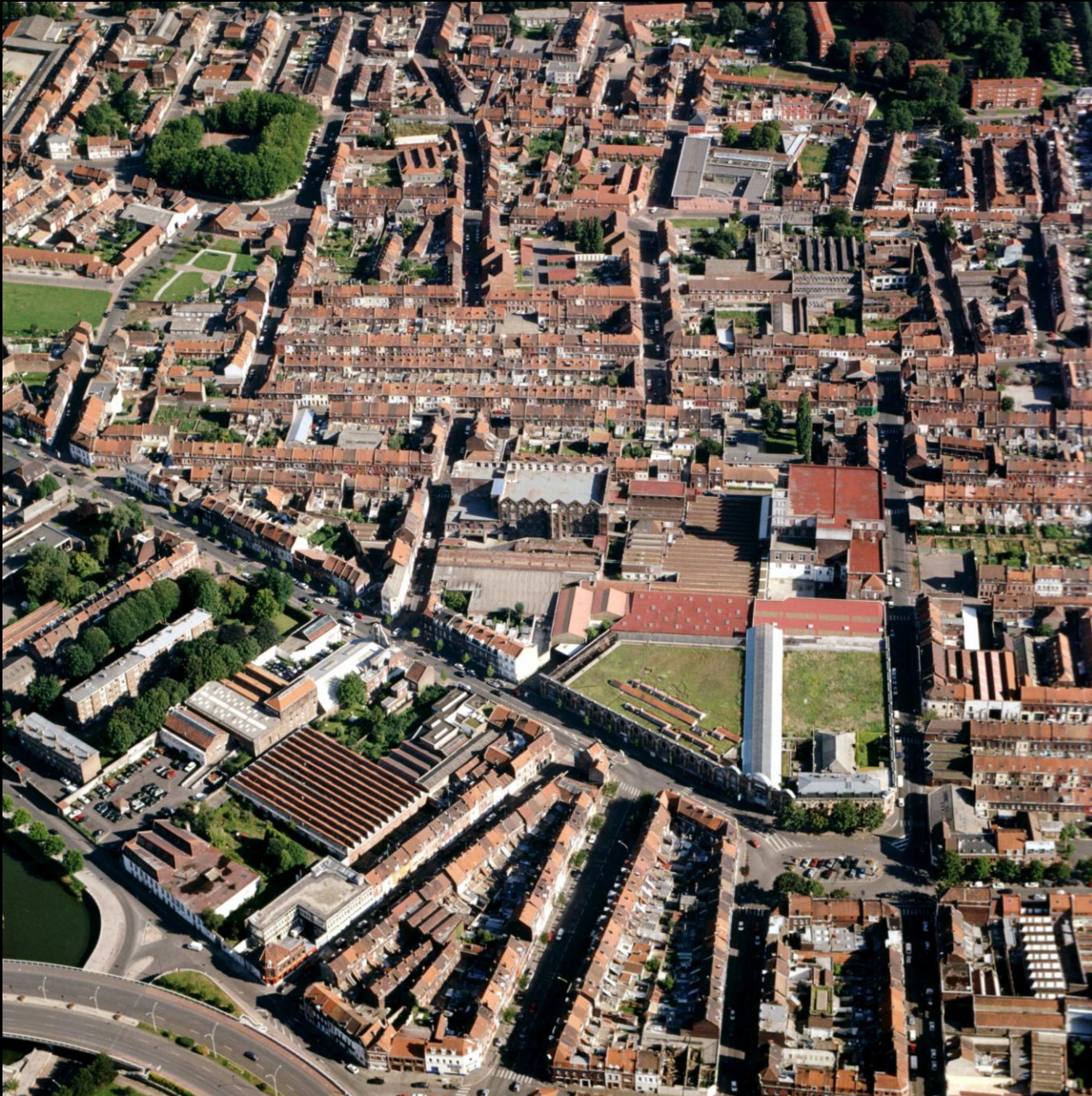
Vue du Pile depuis le nord
