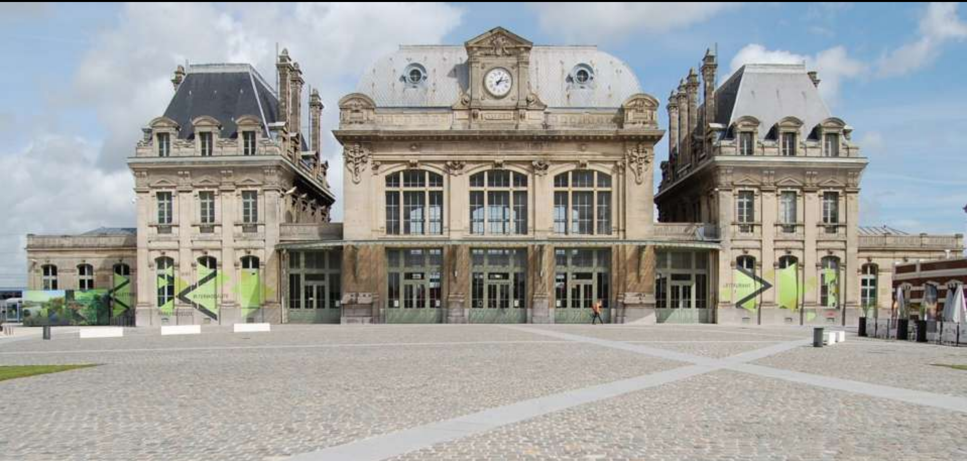
Parvis de la gare après les travaux
