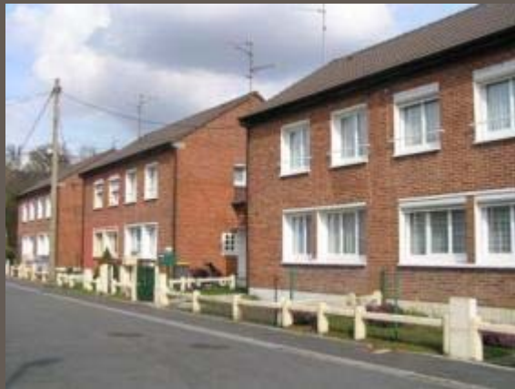
Cité de la Nouvelle Solitude à Vieux-Condé
