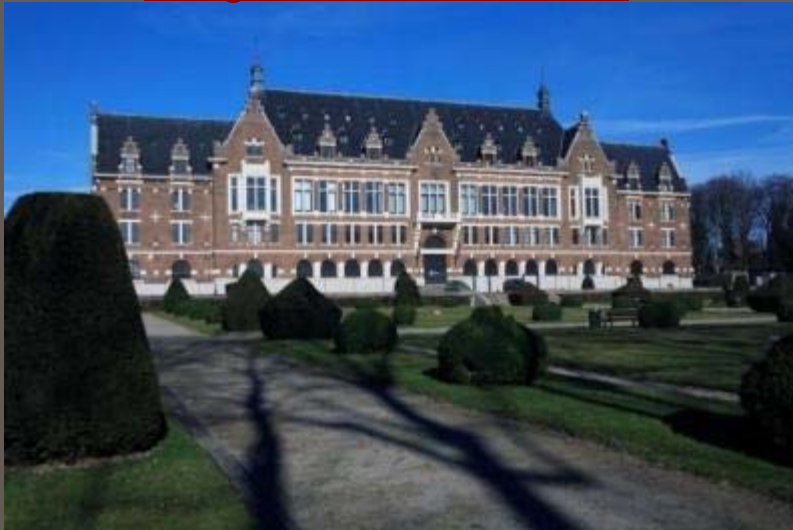
Les Grands Bureaux de la Société des Mines de Lens à Lens
