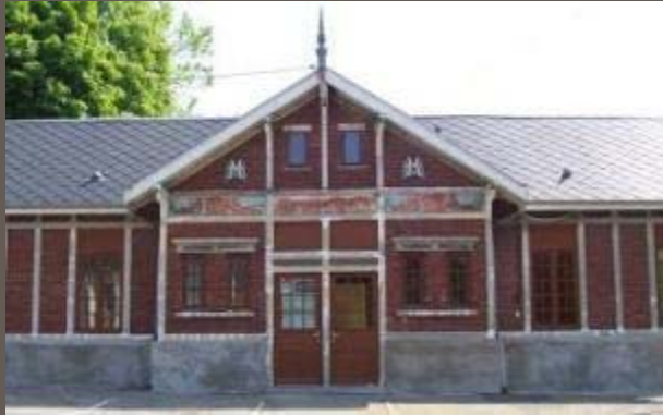
Bâtiment de la goutte de lait, Auchel
