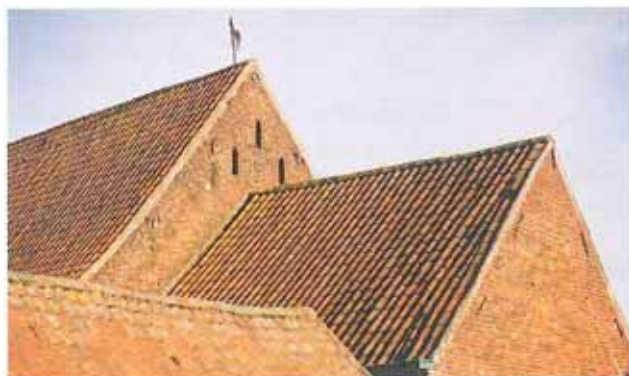
une finition de toit à fleur de maçonnerie
