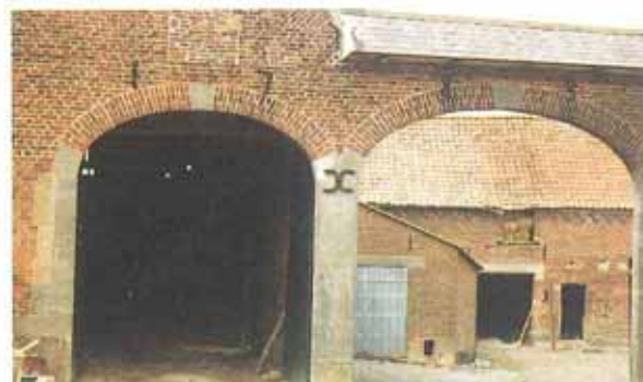
renforçant la cohésion murs/charpentes, l'ancre est inscrite sur le parement des murs. Elle date le bâtiment ou désigne son propriétaire.
