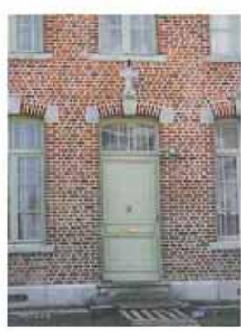
Exemple simplifié du modèle tournaisien sur un bâtiment du XIX e siècle : seul l'arc qui couronne l'ouverture est prétexte à l'alternance des matériaux.
