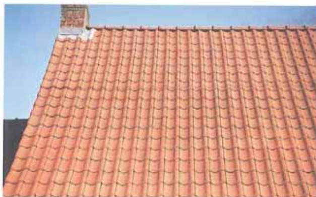
une toiture couverte par de nouvelles tuiles d'une teinte et d'un profil adéquat
