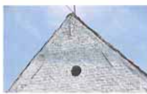
ouverture de ventilation de l'étage
