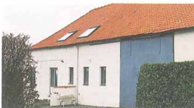
des tabatières placées en toiture d'une grange réaffectée
