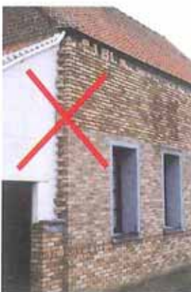
... ne pas remonter une brique devant le parement existant.
