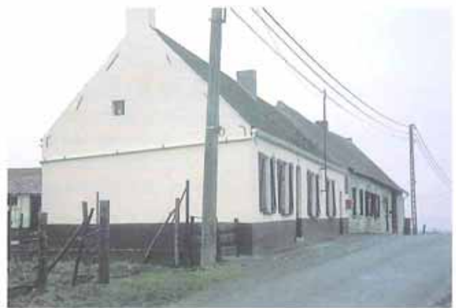
un pignon étroit sans ouvertures
