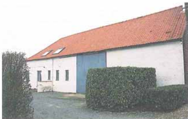
un ensemble de baies verticales, aux dimensions réduites qui s'intègrent dans la façade de la grange
