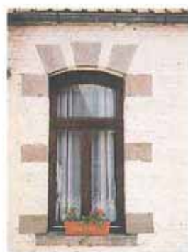
Exemple simplifié du modèle tournaisien sur un bâtiment du XIX e siècle : seul l'arc qui couronne l'ouverture est prétexte à l'alternance des matériaux.
