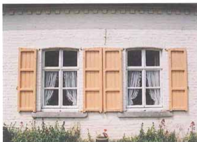
une autre solution pour garder une façade lumineuse : la remise en peinture de volets existants, comme ici sur d'anciennes baies de fenêtres
