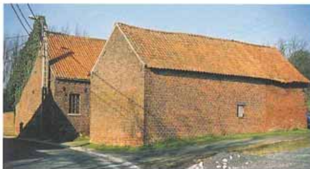
un ensemble en briques apparentes
