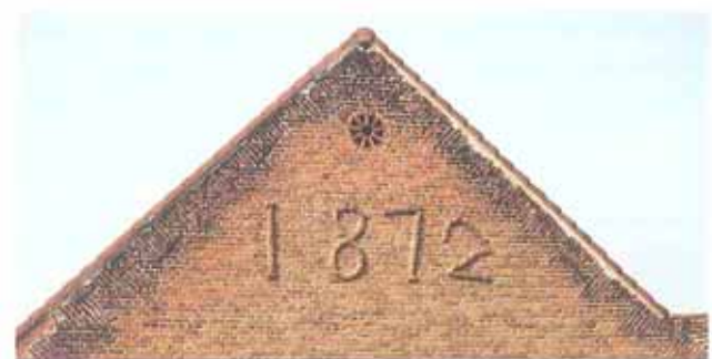
les millésimes de construction en briques saillantes sont courants dans la région.
