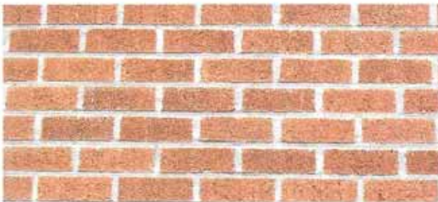
employer une brique de teinte unie qui s'harmonise avec l'ancien bâtiment ...
