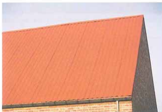
L'utilisation d'un profilé métallique s'avère parfois nécessaire pour couvrir temporairement un bâtiment en attente de rénovation. Dans ce cas, il faut employer la teinte la plus proche de celle de la tuile.
