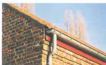
un détail de pied de versant qui préserve la compacité du volume
