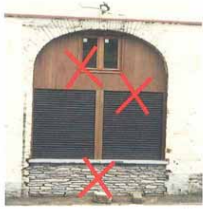
ne surtout pas maçonner la baie, en tout ou en partie...
