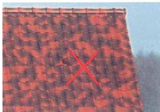
éviter une couverture de toit en tuiles artificiellement «panachées», brunes ou vernissées
