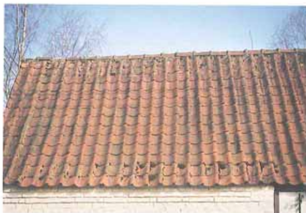
une toiture couverte par de vieilles tuiles
