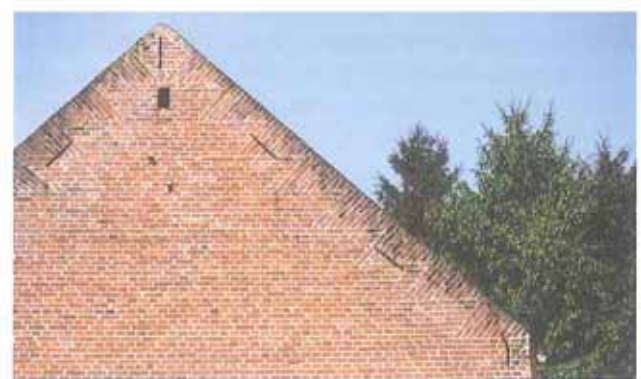
Les briques participent également au traitement particulier des pignons : elles y sont posées en épi , perpendiculairement à la pente de toit. Ce dispositif favorise l'écoulement des eaux.
