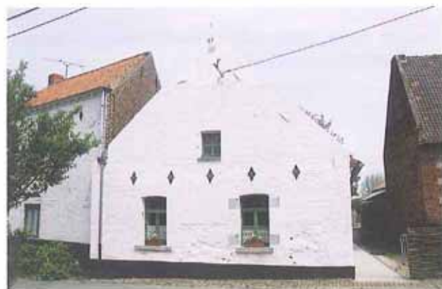
un mur de brique badigeonné de blanc, avec un soubassement distinct
