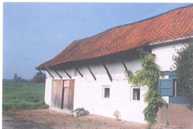
un large débordant de toiture protège parfois les accès aux dépendances agricoles
