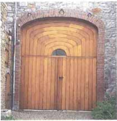
un nouveau panneau de porte plein,
