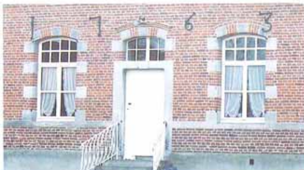
datation de la construction par l'intermédiaire d'une ancre en fer forgé.
