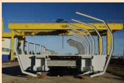
Le prototype d'Urbanbridge® en construction à Fos-sur-Mer © photothèque Eiffage Métal
