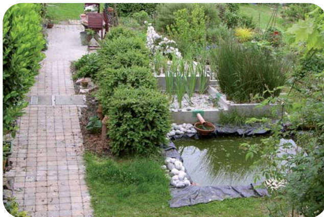
Assainissement par filtre planté.
