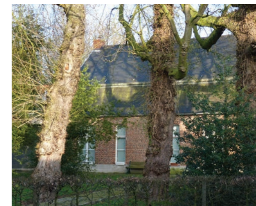
fig. 121_La façade nord-ouest du musée
