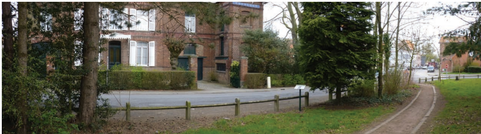
fig. 156_La façade de l'ancienne halle à houblon de Godewaersvelde
