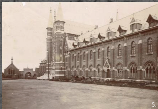
fig 192_Façade nord avec l'abbatiale et la porte d'entrée en 1900
