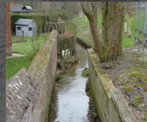
fig. 110_La becque depuis le pont de la rue du Mont des Cats
