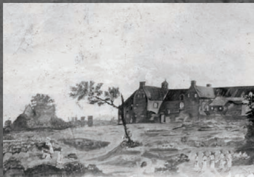
fig 190_Façade nord de l'ancien couvent des Antonins
