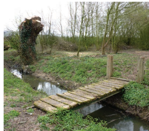
fig. 098_L'actuel pont qui franchit la «Vleter Becque»
