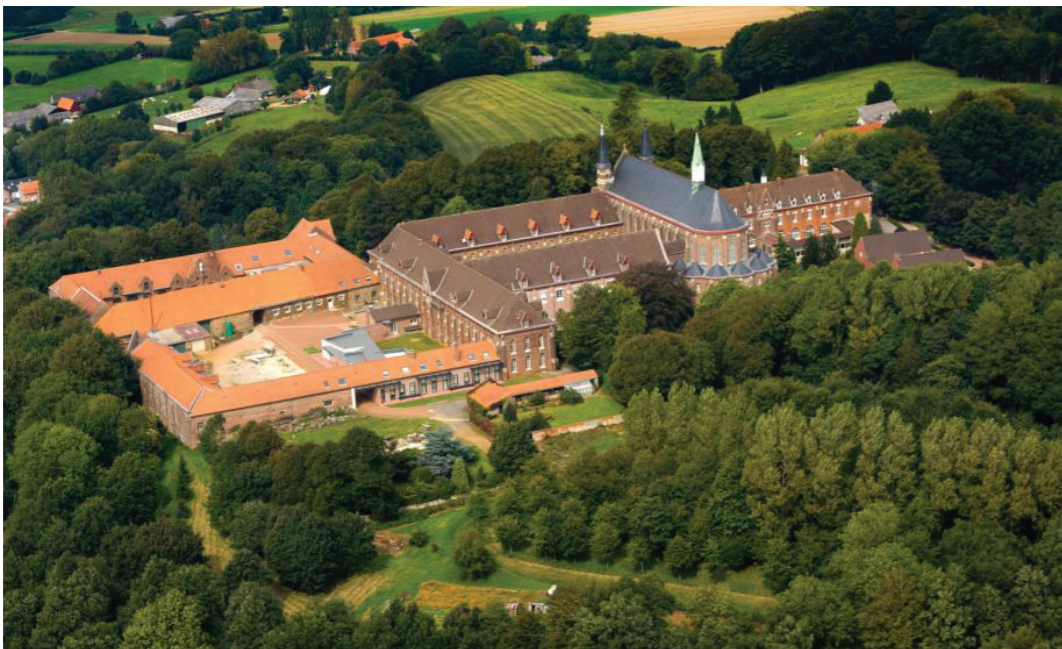
fig. 184_Vue aérienne de la face sud-ouest de l'abbaye
