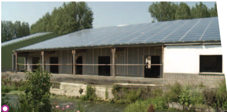
Réhabilitation de l'ancienne scierie de Conchy-sur-Canche
