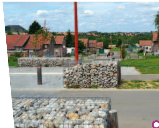
Rénovation de quartiers à Calonne-Ricouart
