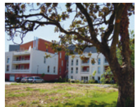
Le Domicile Services, dans le centre-ville, à deux pas des commerces
