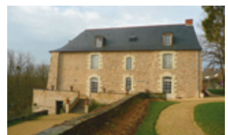
... et après rénovation
