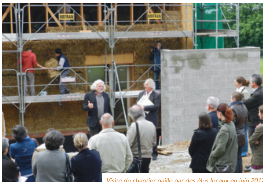
Visite du chantier paille par des élus locaux en juin 2012
