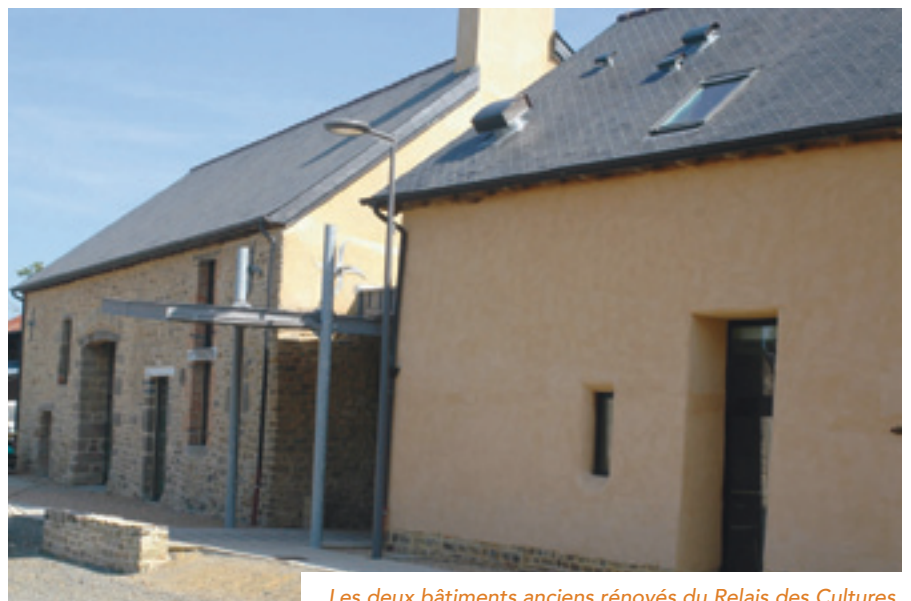
Les deux bâtiments anciens rénovés du Relais des Cultures.
