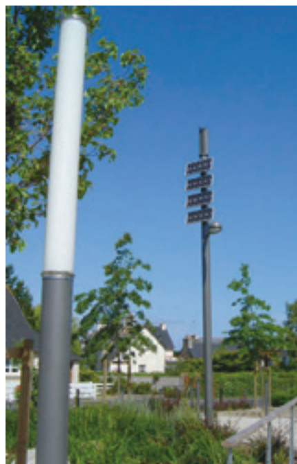
Un lampadaire autonome en énergie.
