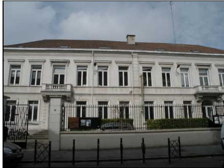
Photo 1 : Bâtiment du CAUE du Nord
