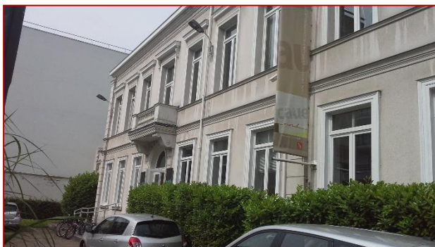
Figure 1 : Façade principale de bâtiment de CAUE du nord
