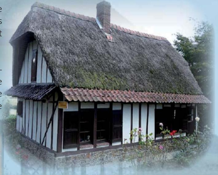
Les murs des chaumières sont formés de colombage ainsi que de torchis, celui-ci étant un mélange d'argile, de chaux, de paille, maintenus par des lattes. Un enduit à base de lait de chaux est présent sur les murs afin de les protéger des intempéries.
