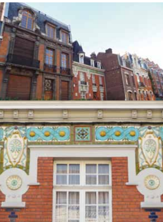
Rang de maisons de la rue de la Louvière datant du début du xx e siècle. État actuel
