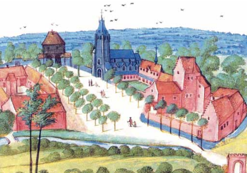
Détail de la planche sur le prieuré de Fives
