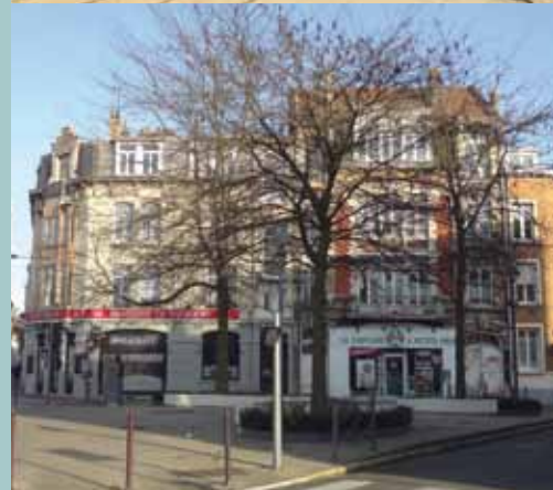
Maison à usage d'habitation et de commerce. Ferronneries de la porte d'entrée, détail
