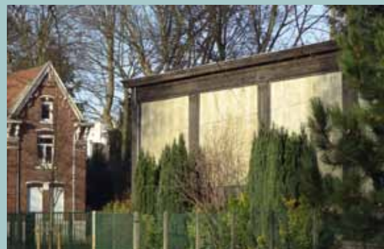
Traces de l'ancien jardin botanique : la maison du gardien et une serre. Etat actuel
