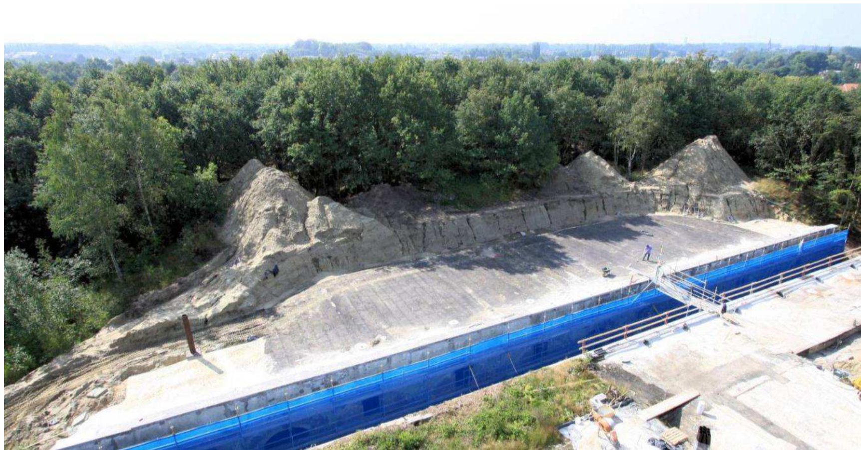
Fase 1 restauratie (2011): herstel waterdichting boven lokalen voor zachte recreatie en cultuur
