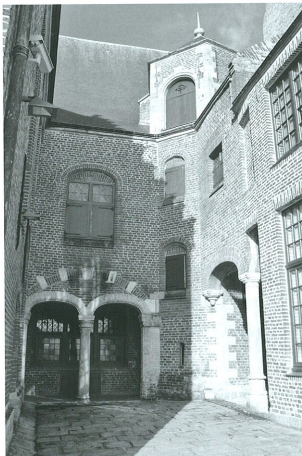
Fig. 3 - Cassel, hôtel de la Noble Cour, arrière de l'édifice : ailes ouest (à gauche) et est (à droite). Entre elles, galeries de distribution (au fond et à droite) greffées sur la tourelle d'escalier.
